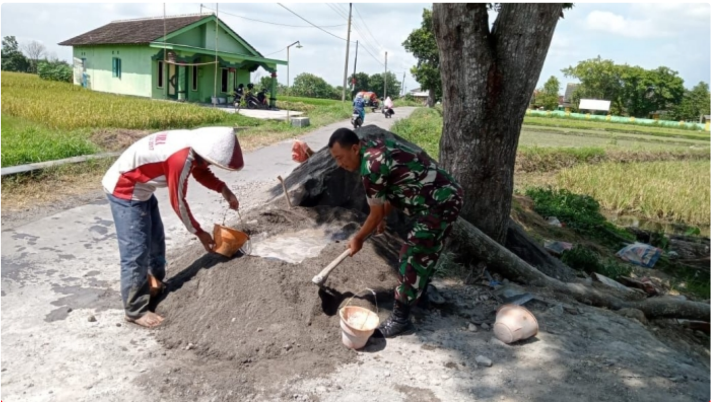
Wujudkan Kemanunggalan TNI dan Rakyat, Babinsa Wonosari Bantu Buat Talud Jalan
